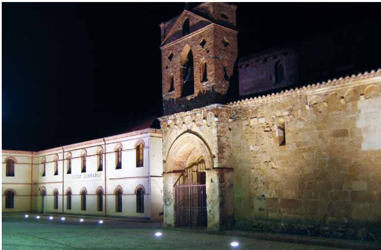
Fig. 6 – Scorcio del complesso monumentale di Sant'Adriano con il portale della chiesa.
