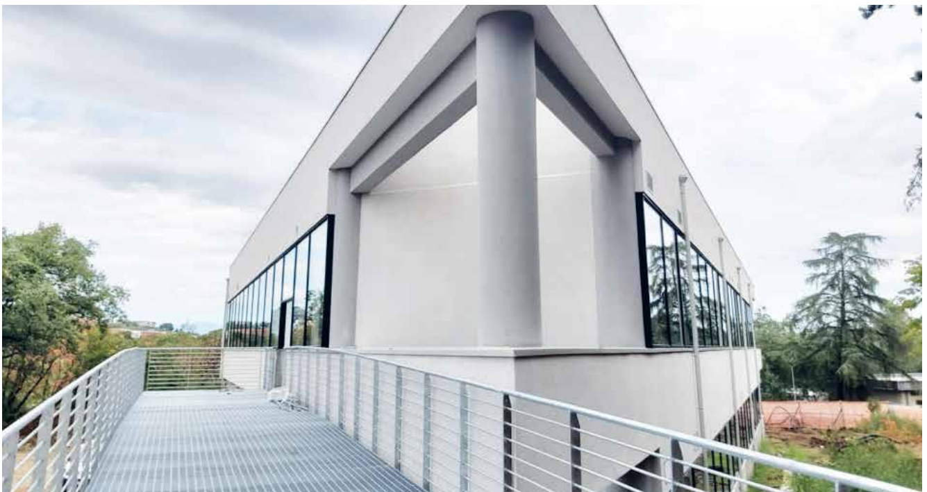
Fig. 14 – Il nuovo edificio per l'attività didattica del corso di laurea magistrale in Medicina e Chirurgia – TD, nel campus dell'Università della Calabria.
