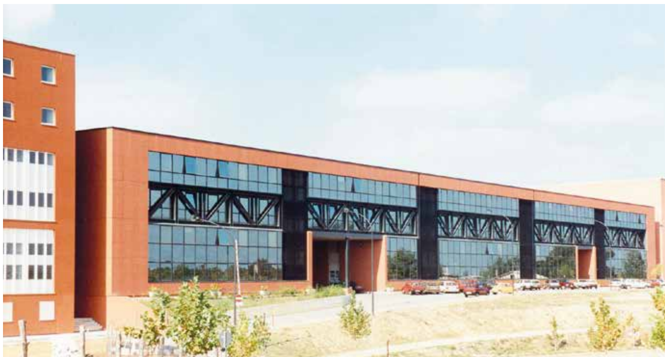
Figg. 18, 19 – Gli edifici di alcuni dipartimenti e laboratori di Ingegneria sul lato occidentale del ponte “Pietro Bucci” e la sede dell’Amministrazione centrale dell’Università della Calabria, sul lato orientale del ponte, dopo il completamento dei lavori di costruzione, nel 1994.
